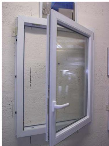
Exemple de châssis ouvrant à la Française
